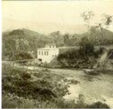
Foto: 32: Sede da Usina Força e Luz – Proprietário Geraldo Guimarães. Disponível em: www.rotarycamposaltos.blogspot.com . Acesso em março de 2009
